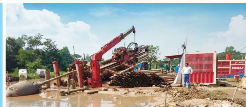
GD3500-L型水平定向钻机 江西施工现场 GD3500-L HDD project site in Jiangxi Province
