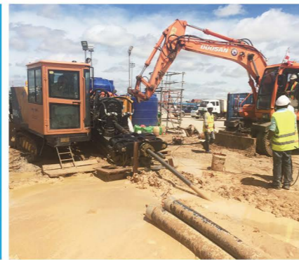
GS350-LS型水平定向钻机 菲律宾施工现场 GS350-LS HDD project site in Philippines
