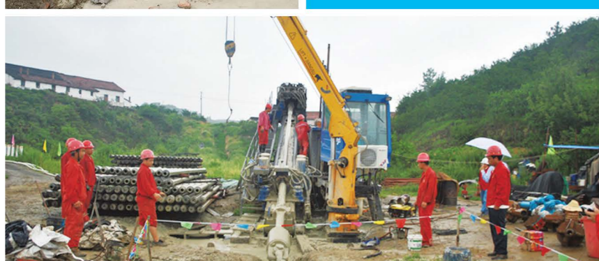
GD320-L 型水平定向钻机 江苏施工现场 GD320-L HDD project site in Jiangsu Province GD800-L 型水平定向钻机 陕西施工现场 GD800-L HDD project site in Shanxi Province
