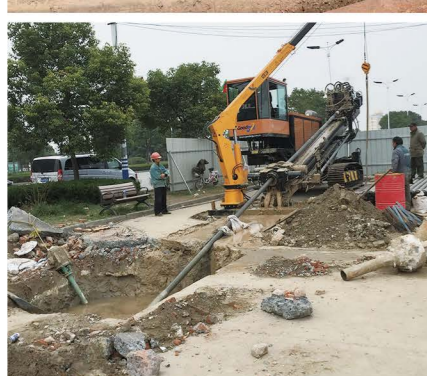
GD320-L 型水平定向钻机 江苏施工现场 GD320-L HDD project site in Jiangsu Province GD800-L 型水平定向钻机 陕西施工现场 GD800-L HDD project site in Shanxi Province
