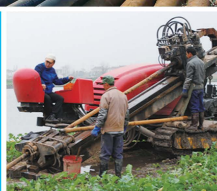
GD3500-L 型水平定向钻机 湖北施工现场 GD3500-L HDD project site in Hubei Province
