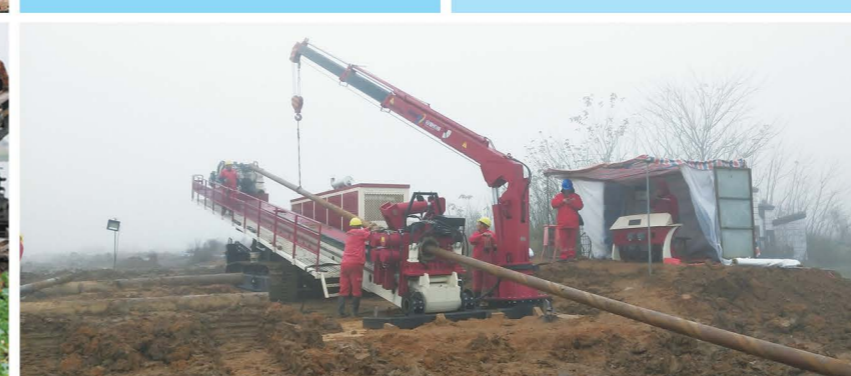
GD3500-L型水平定向钻机 江西施工现场 GD3500-L HDD project site in Jiangxi Province
