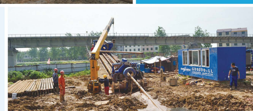
GD320D-L 型水平定向钻机 上海施工现场 GD320D-L HDD project site in Shanghai
