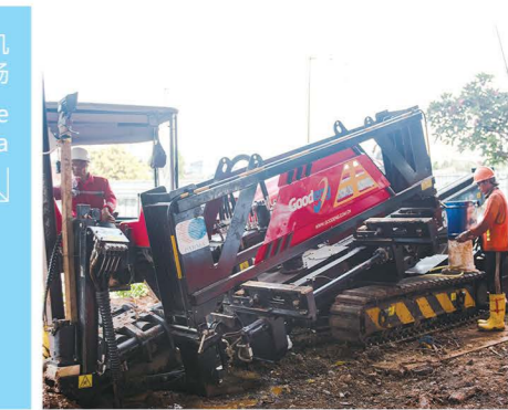
GS900-LS型水平定向钻机 印度施工现场 GS900-LS HDD project site in India GS6000-T型水平定向钻机 孟加拉施工现场 GS6000-T HDD project site in Bangladesh
